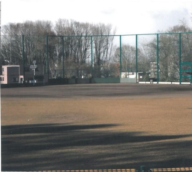
完成した高台野球場
