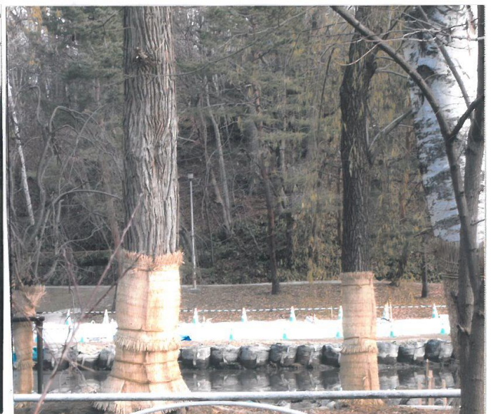
工事中のボート池周辺
