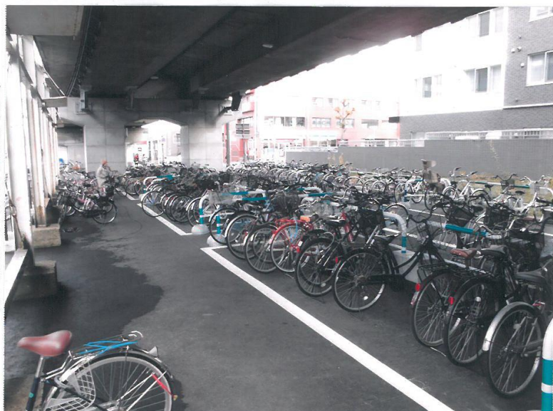
南平岸駅高架下新駐輪場
